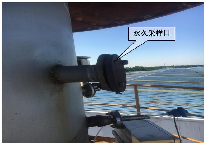
图 4.2-6 (1) 多效高级除尘+沸石转轮+RTO 装置排气筒永久采样口
