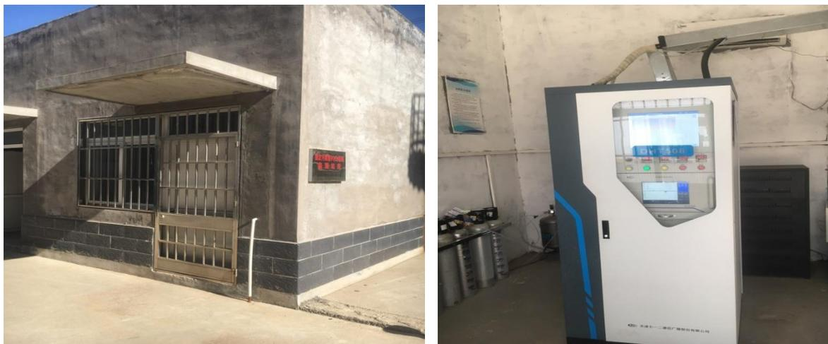
图 4.2-7 RT0 废气在线监测仪安装情况
