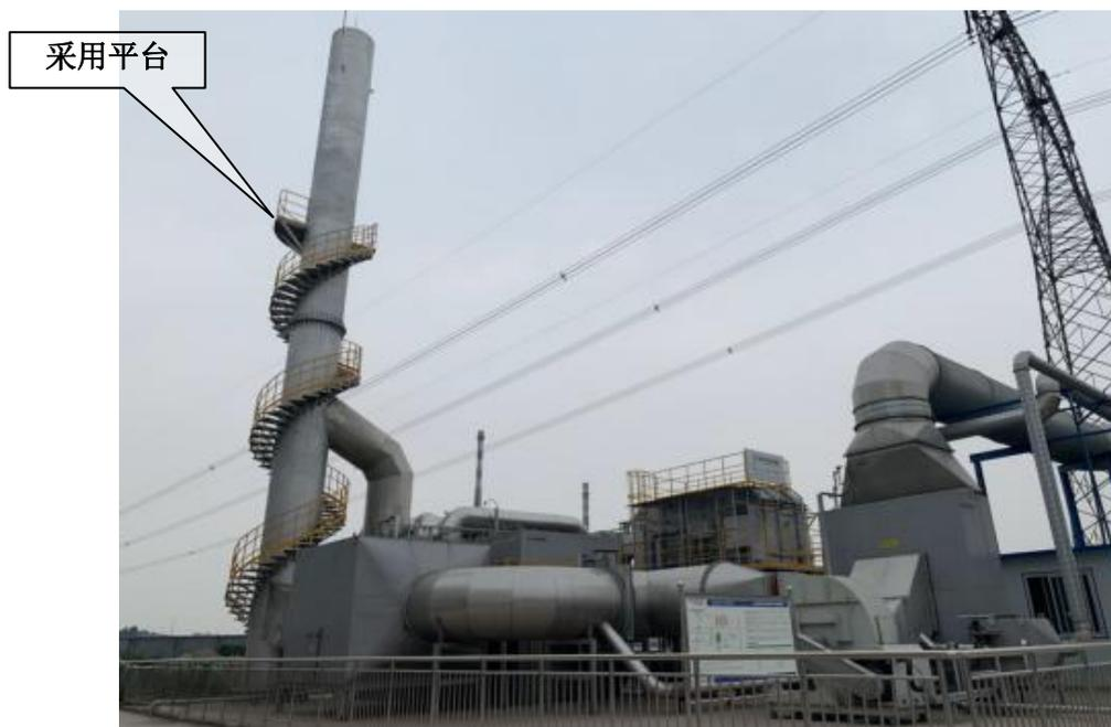
图 4.2-6 (2) 多效高级除尘+沸石转轮+RT0 装置排气筒采样平台
