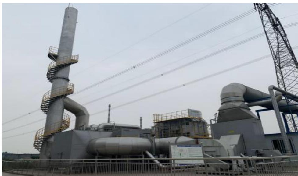
图 4-1 (2) 依托的现有“多级高效除尘+沸石转轮浓缩+RT0”及排气筒
